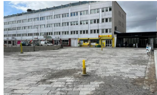
TORGET RIKTNING VÄSTERUT: På bilden syns torget med ny markbeläggning och påbörjade nya belysningsstolpar. Entrén till pendeltågsstationen skymtar i bakgrunden.
