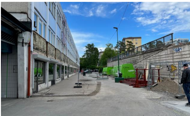
TORGSTRÅKET RIKTNING NORRUT: På bilden syns stationsbyggnadens fasad med lokaler i gatuplan. Till höger syns en upphöjd parkeringsyta i väntan på att bli bebyggd.
